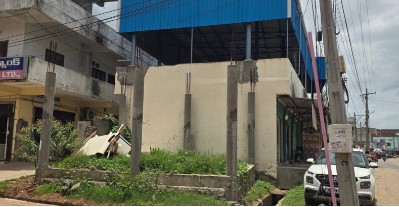
రెండేళ్లుగా పిల్లలకే పరిమితమైన నిర్మాణం ....
